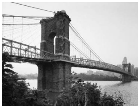
Fig. 7 Foto del ponte sospeso sull'Ohio
