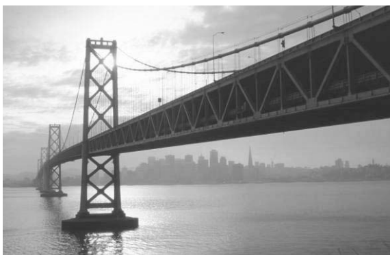
Fig. 12 Foto del San Francisco-Oakland Bay Bridge
